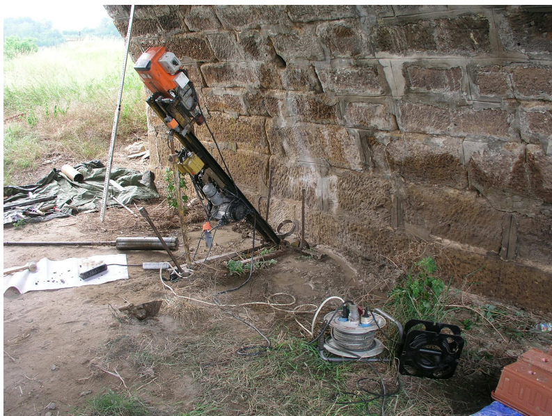
Vrt Pvs 2, přistavení vrtné soupravy
