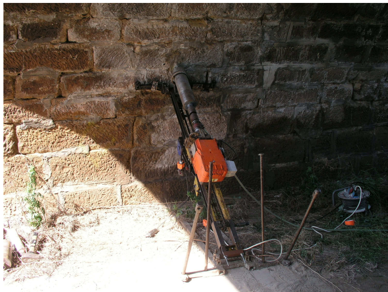
Vrt Pvs 1, přistavení vrtné soupravy
