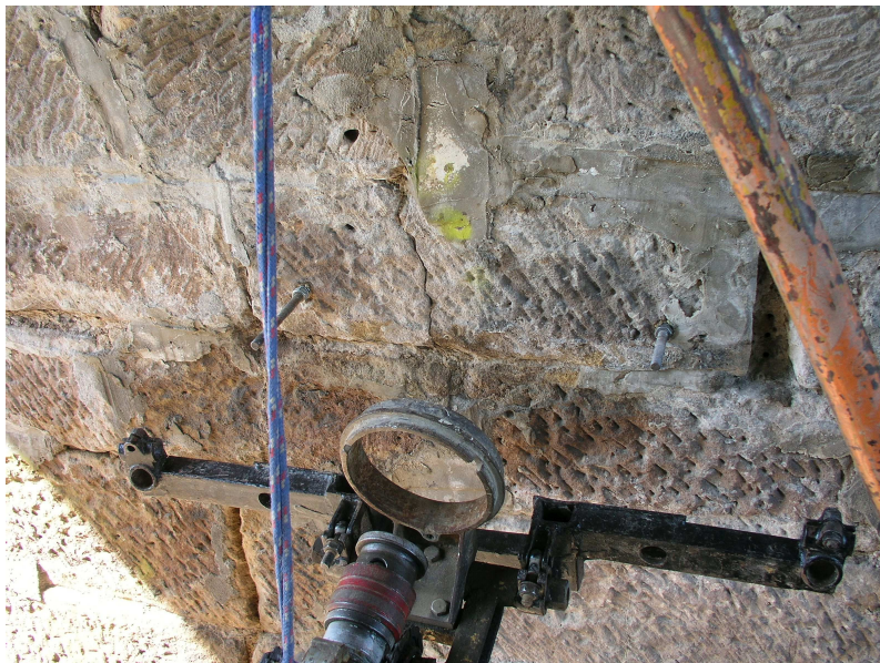
Vrt Pvs 1, kotvení vrtné soupravy
