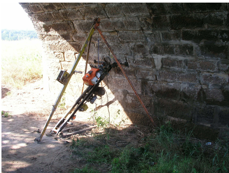
Vrt Pvs 1, přistavení vrtné soupravy
