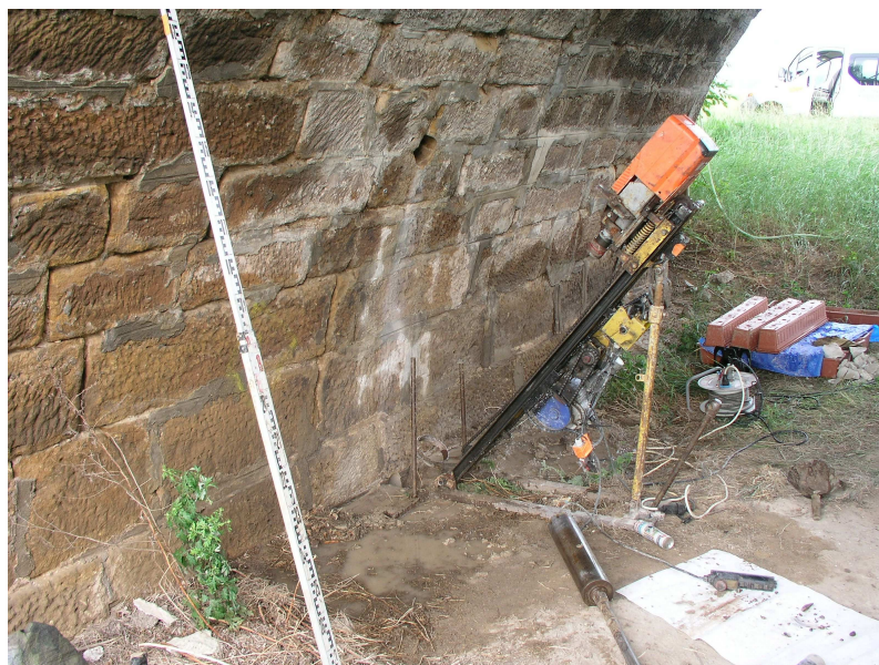
Vrt Pvs 2, ukotvení vrtné soupravy
