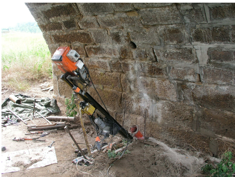
Vrt Pvs 2, propažení úvodních návrtů
