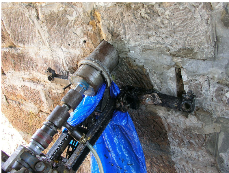
Vrt Pvs 1, vrtání diamantovou korunkou
